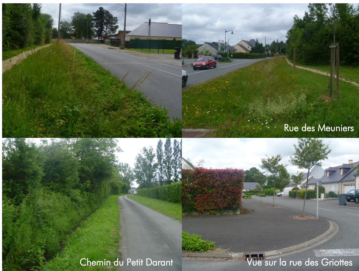
Figure 23 : Reportage photographique des différentes vues et voiries autour du site d'étude
