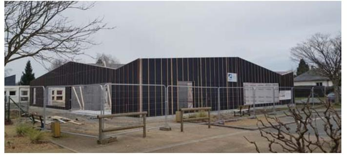
Le chantier périscolaire prend forme avec l'élévation de la structure constituée de panneaux bois intégrant l'isolation. Prochaine étape, montage de la charpente.
