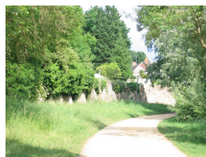
Mur d'enceinte du Château du Plessis-Macé
