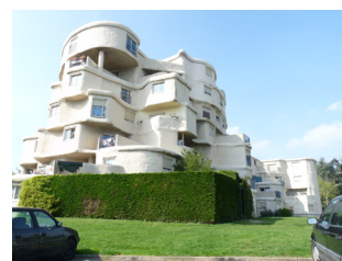
Les Kalougines Angers
