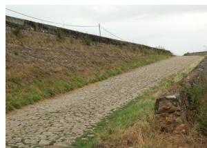
Loire-Authion Saint-Mathurin-sur-Loire rampe d'accès
