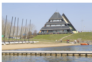
Centre nautique Angers
